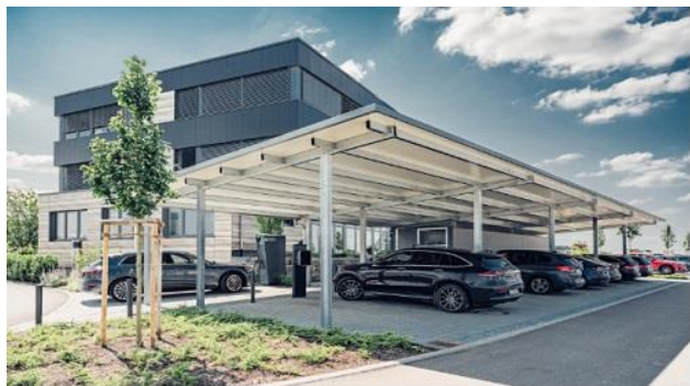
Bild: BayWa r.e. Solar Energy Systems GmbH
