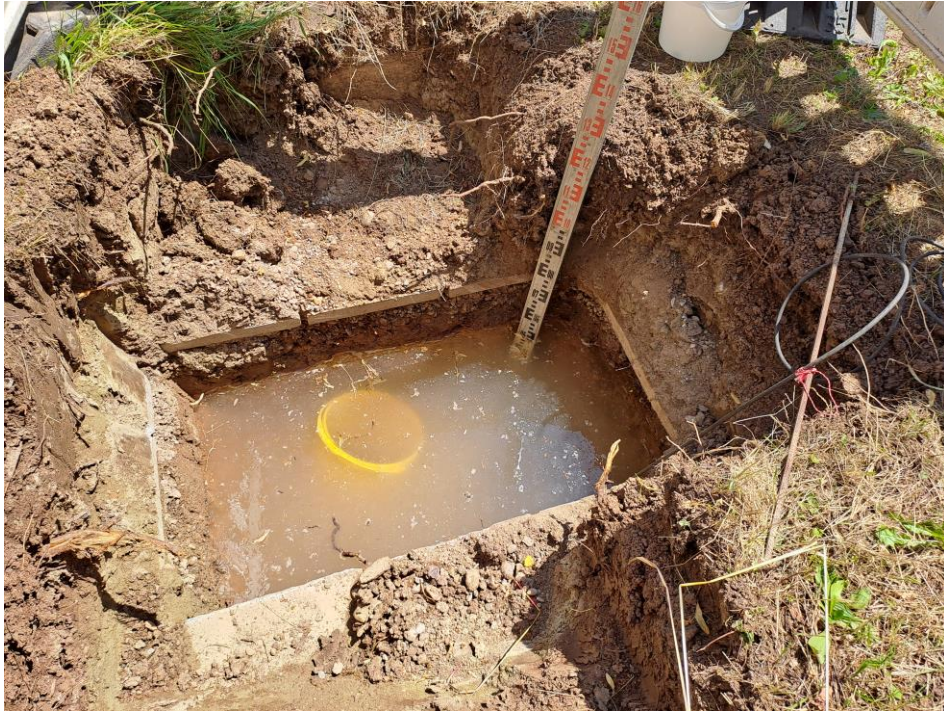
Foto Nr. 7 Versickerungsversuch SG4 - Beginn
