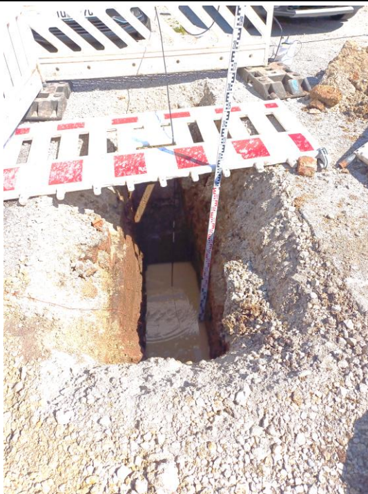
Foto Nr. 2 Versickerungsversuch SG1 – Ende 2,8 h
