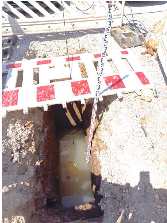
Foto Nr. 1 Versickerungsversuch SG1 - Beginn
