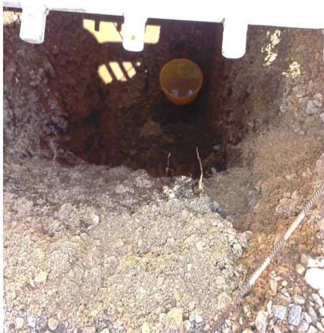
Foto Nr. 4 Versickerungsversuch SG2 – Ende 3,4 h
