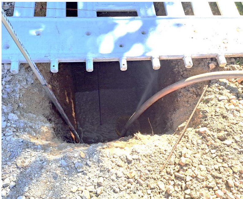
Foto Nr. 3 Versickerungsversuch SG2 - Beginn
