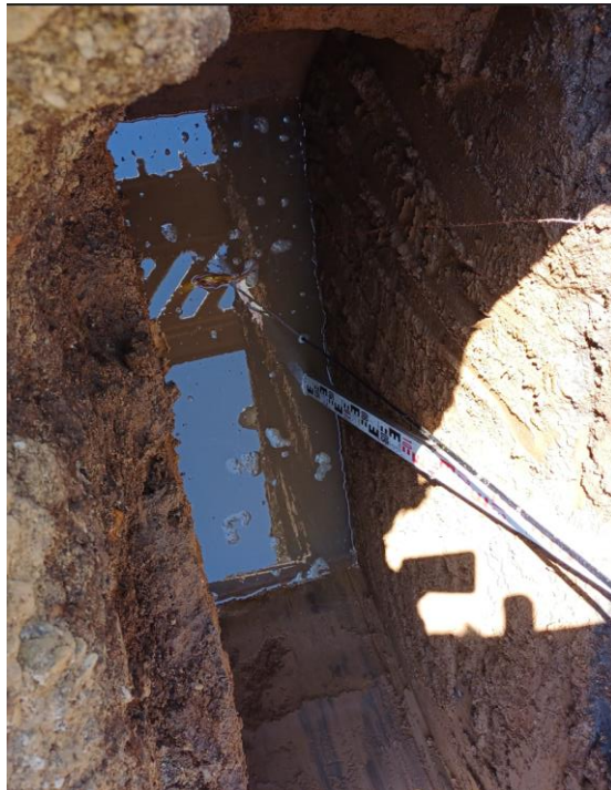
Foto Nr. 5 Versickerungsversuch SG3 - Beginn
