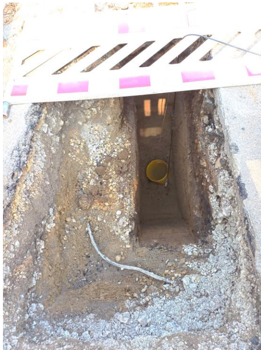
Foto Nr. 6 Versickerungsversuch SG3 – Ende 6,5 h
