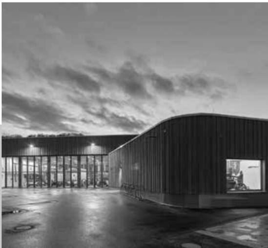
Bei der Konstruktion konnte einiges an CO<sub>2</sub> reduziert werden. Gegenüber einem konventionellen Massiv- oder Stahlbau mit ca. 85 Tonnen CO<sub>2</sub> Freisetzung liegt dieser Wert bei Holz bei ca. sechs Tonnen CO<sub>2</sub>. Zusätzlich wurde die regionale Baukultur gefördert, denn das FSZ-zertifizierte Baumaterial stammt aus dem Schwarzwald und dem Allgäu und wurde in der Region gefertigt.
