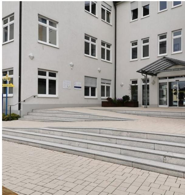
Beim Bau des neuen Rathauses Leimen (2016) wurde Wert gelegt auf eine barrierefreie Erschließung und Nutzung des Gebäudes. Zum Haupteingang führt eine taktile Blindenleitlinie, die im Gebäudeinneren weitergeführt wird. Ein elektrischer Türöffner erleichtert Menschen im Rollstuhl den Zugang.
