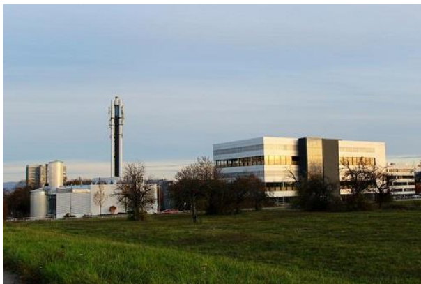
BHKW Obere Viehweide; Archivbild: swt/Schermaul
