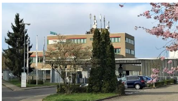
Bild: Siemens Kilchberg
