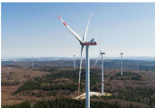
Windpark Amtenhäuser Berg; Bild: swt/Marquardt
