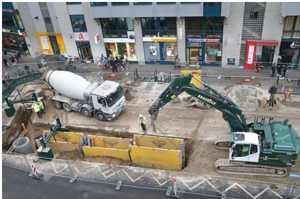
Europaplatz-Baustelle im September
