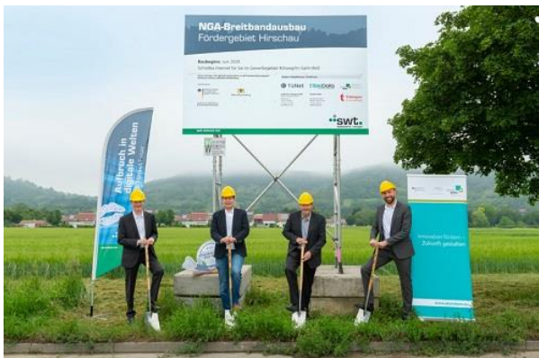
Spatenstich 2020. Bild: swt
