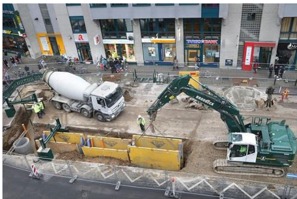
Europaplatz-Baustelle im September
