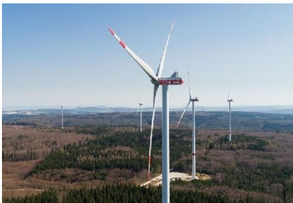
Windpark Amtenhauser Berg; Bild: swt/Marquardt
