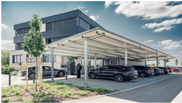
Bild: BayWa r.e. Solar Energy Systems GmbH
