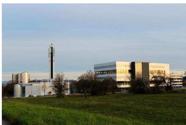
BHKW Obere Viehweide; Archivbild: swt/Schermaul
