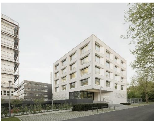
Bild: SüdWestStrom /B. González
