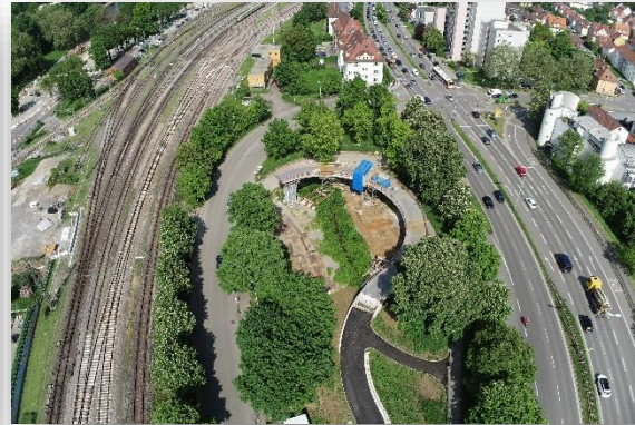
Luftbild Radbrücke West - Südseite
