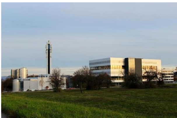
BHKW Obere Viehweide; Archivbild: swt/Schermaul
