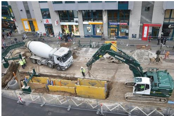
Europaplatz-Baustelle im September
