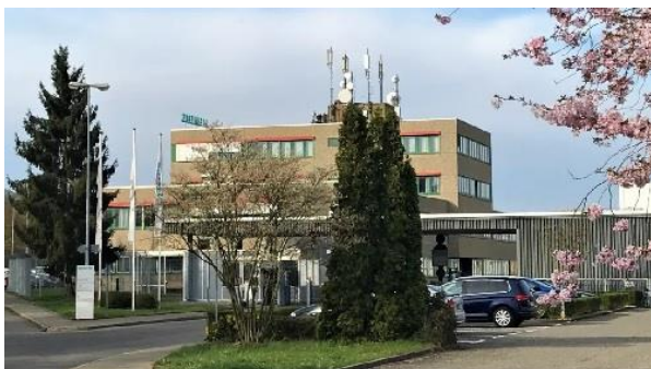
Bild: Siemens Kilchberg
