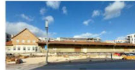
Güterhalle, Eisenbahnstrasse, Alter Güterbahnhof, Tübingen
