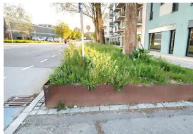
Stahlaufkantung beim 60cm Höhengsprung im Osten
