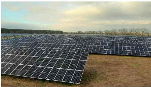
Solarpark "Metzdorf II"; Bild: swt
