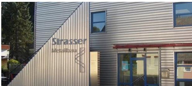
Bild: Strasser Metallbau GmbH
