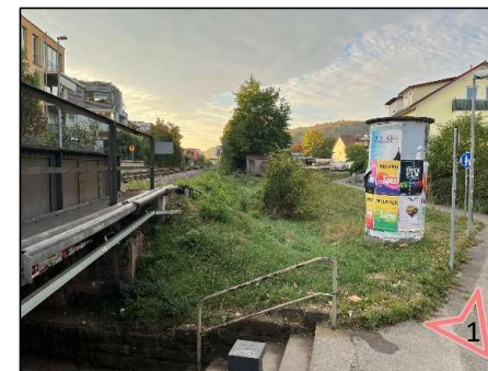
Kanalstraße: Blick Richtung Süden
