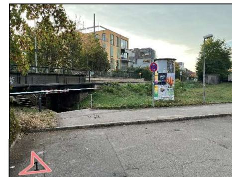
Kanalstraße: Blick Richtung Osten
